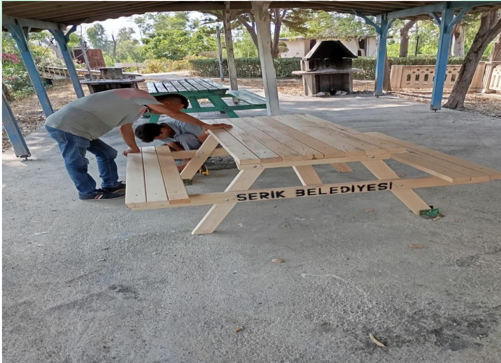
İlgi Fotoğraf: Boğazkent Balıkçı Barınağı bakım, onarım ve tamiratları yapılmıştır.
