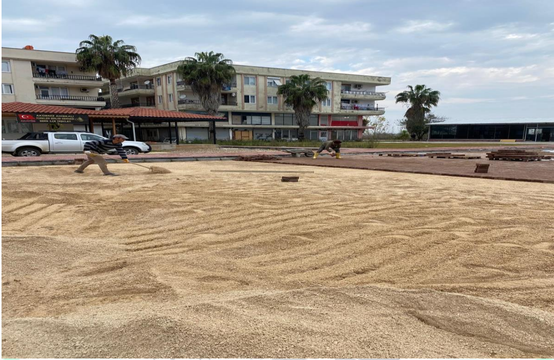
İlgi Fotoğraf: Belek Mahallesi Acısu Kenarına otopark yapılmıştır.
