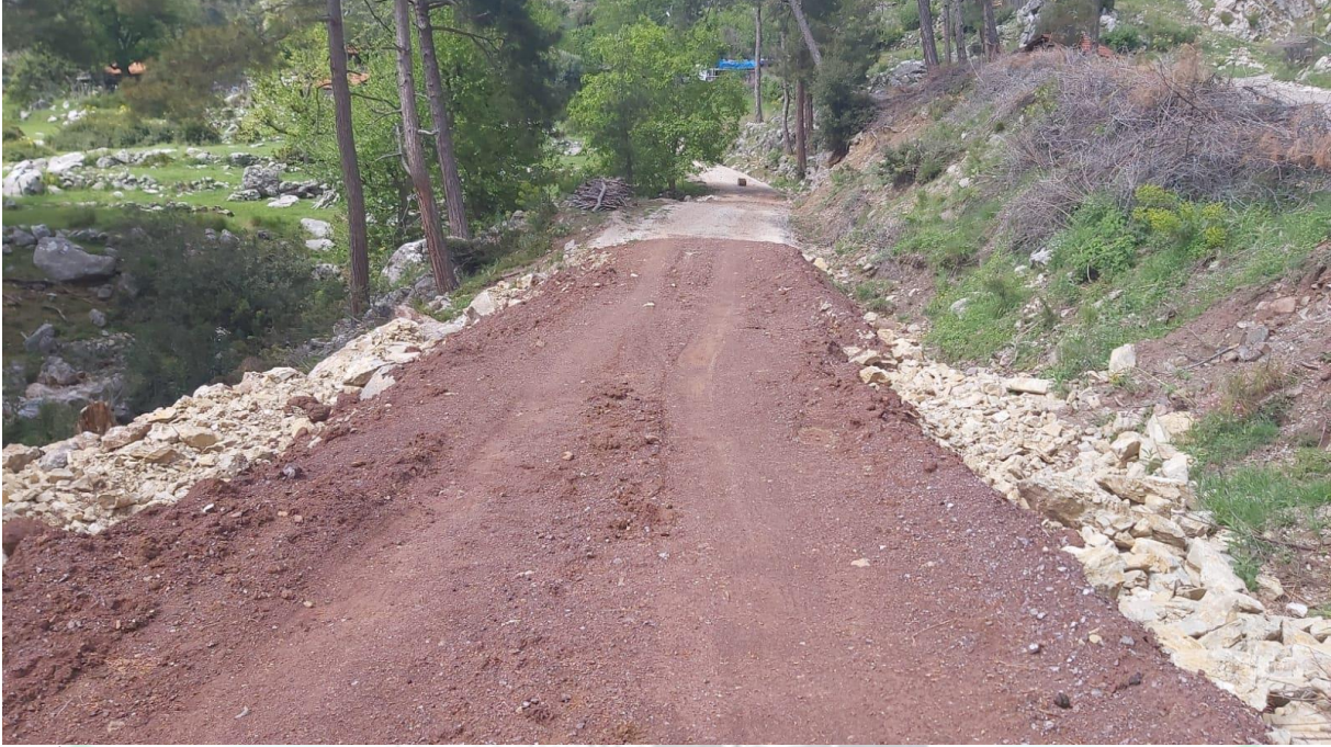
İlgi Fotoğraf: Demirciler Mahallesi heyelan olmuş yolu onarım çalışması yapılmıştır.
