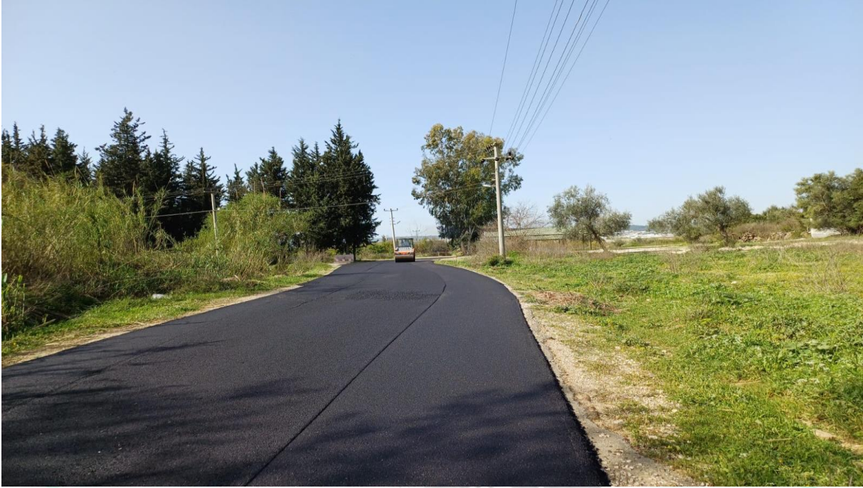
İlgi Fotoğraf: Aşağıoba Mahallesi sıcak asfalt serim çalışması yapılmıştır
