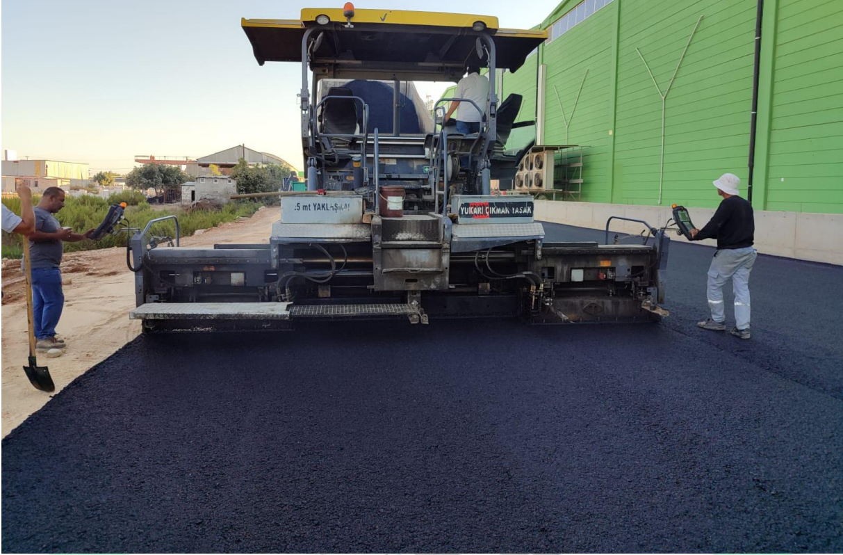
İlgi Fotoğraf: Cumalı Mahallesi Kardelen Caddesi sıcak asfalt serim çalışması yapılmıştır
