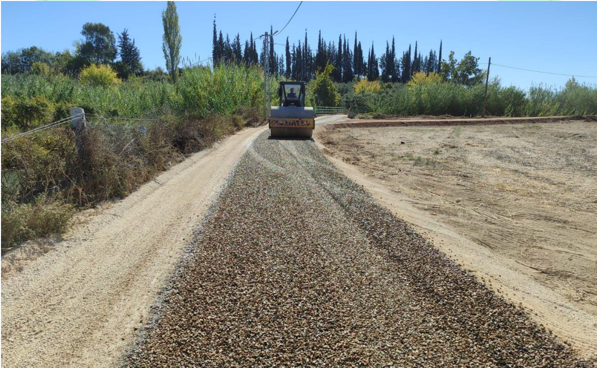
İlgi Fotoğraf: Yanköy Mahallesi sathi asfalt serim çalışması yapılmıştır
