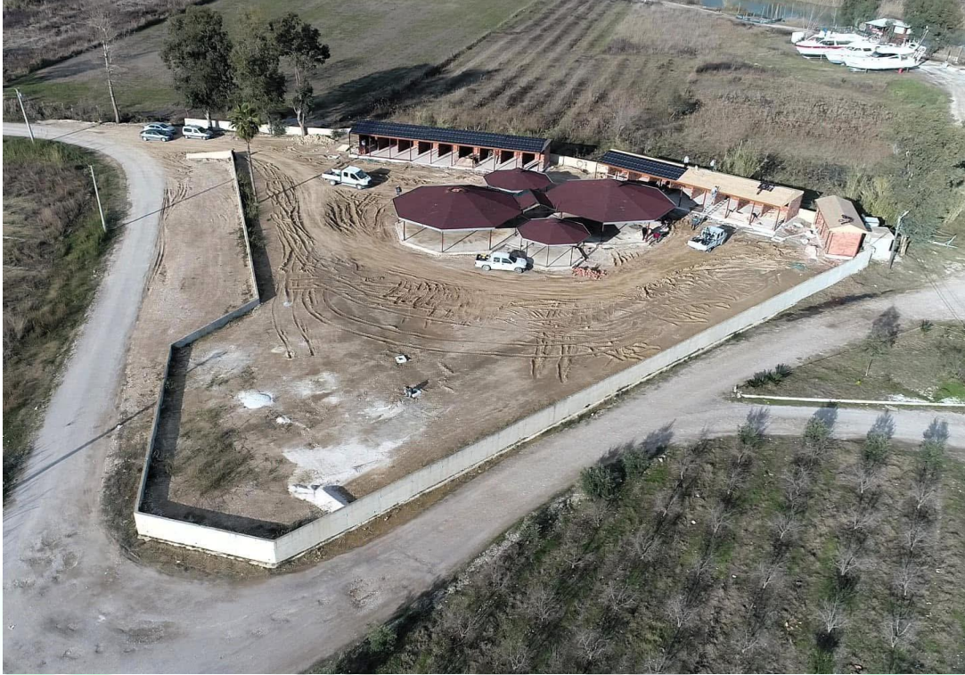
İlgi Fotoğraf: Boğazkent Balık Pazarı proje ve altyapı çalışmaları devam etmektedir.
