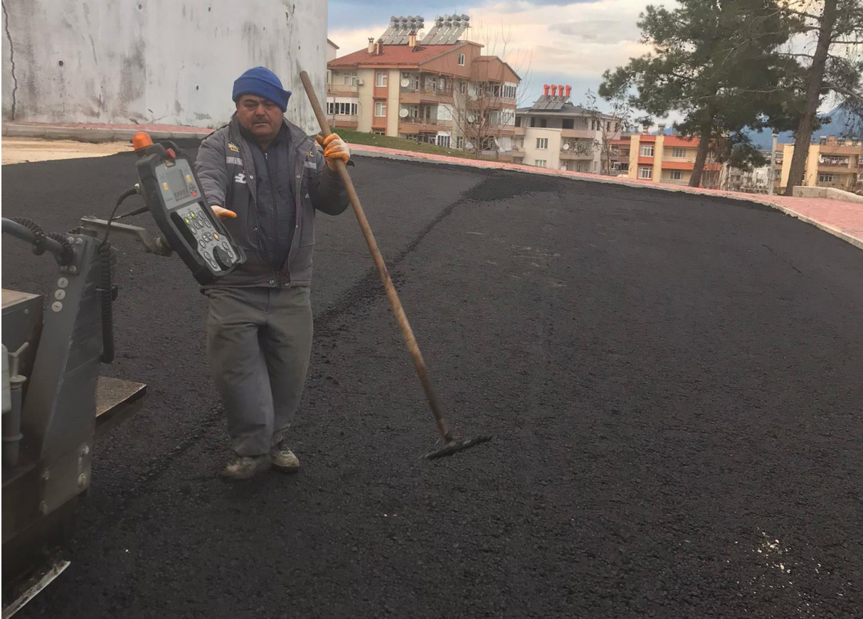
İlgi Fotoğraf: Merkez Mahallesi Ertuğrul Gazi Anadolu Lisesi otopark alanı sıcak asfalt serim çalışması yapılmıştır
