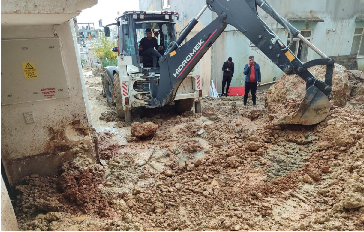
İlgi Fotoğraf: Merkez Mahallesi 3012 Sokak'ta üzerine kaya düşen evin temizlik çalışması yapılmıştır.
