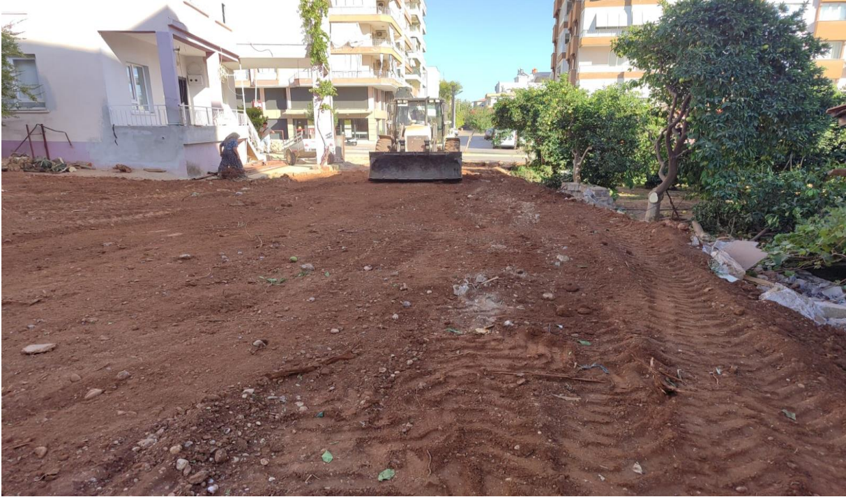
İlgi Fotoğraf: Kökez Mahallesi 3054 Sokak imar yolu açma çalışması yapılmıştır.
