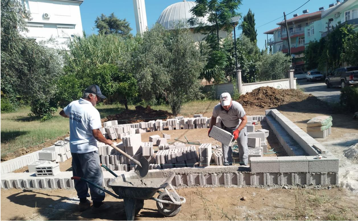
İlgi Fotoğraf: Akçaalan Mahallesi muhtarlık hizmet binası yapım çalışması yapılmıştır. (başlangıç)
