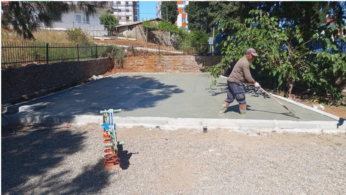
İlgi Fotoğraf: Orta Mahalle Kazım Karabekir Anaokulu Bahçesi oyun alını yapım çalışması yapılmıştır
