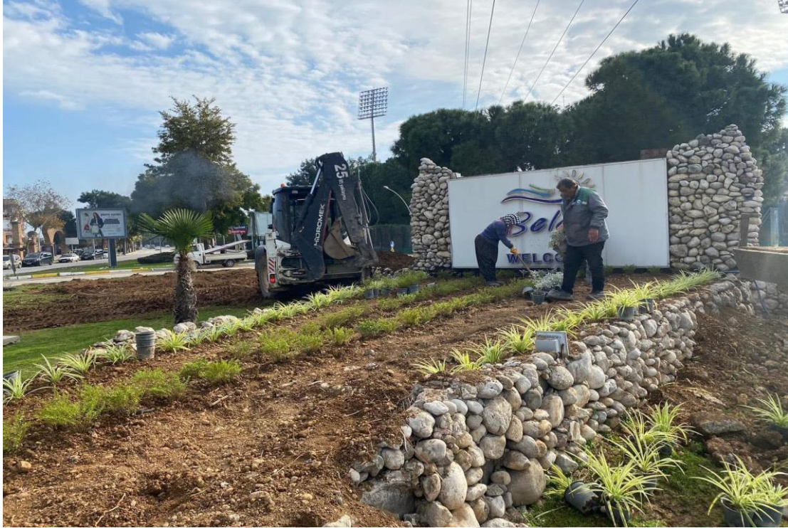
İlgi Fotoğraf: Belek Kavşağı yenileme çalışmaları yapılmıştır.
