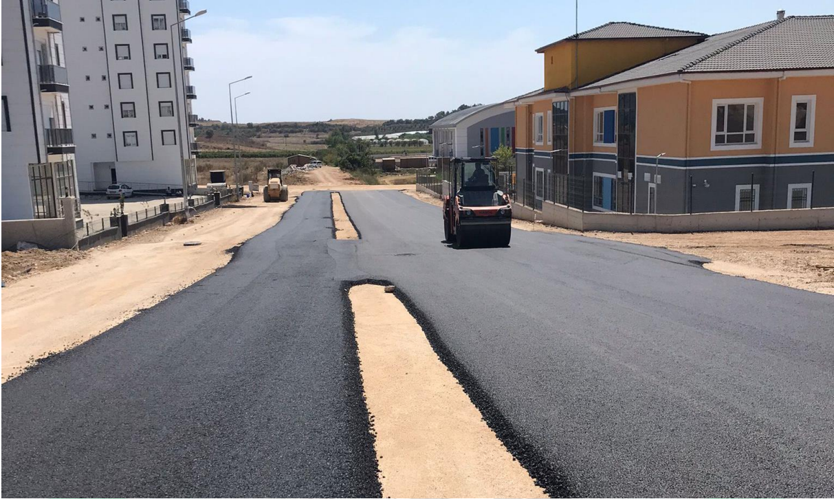
İlgi Fotoğraf: Gedik Mahallesi Ahmet Rıfat Gököz Caddesi sıcak asfalt serim çalışması yapılmıştır
