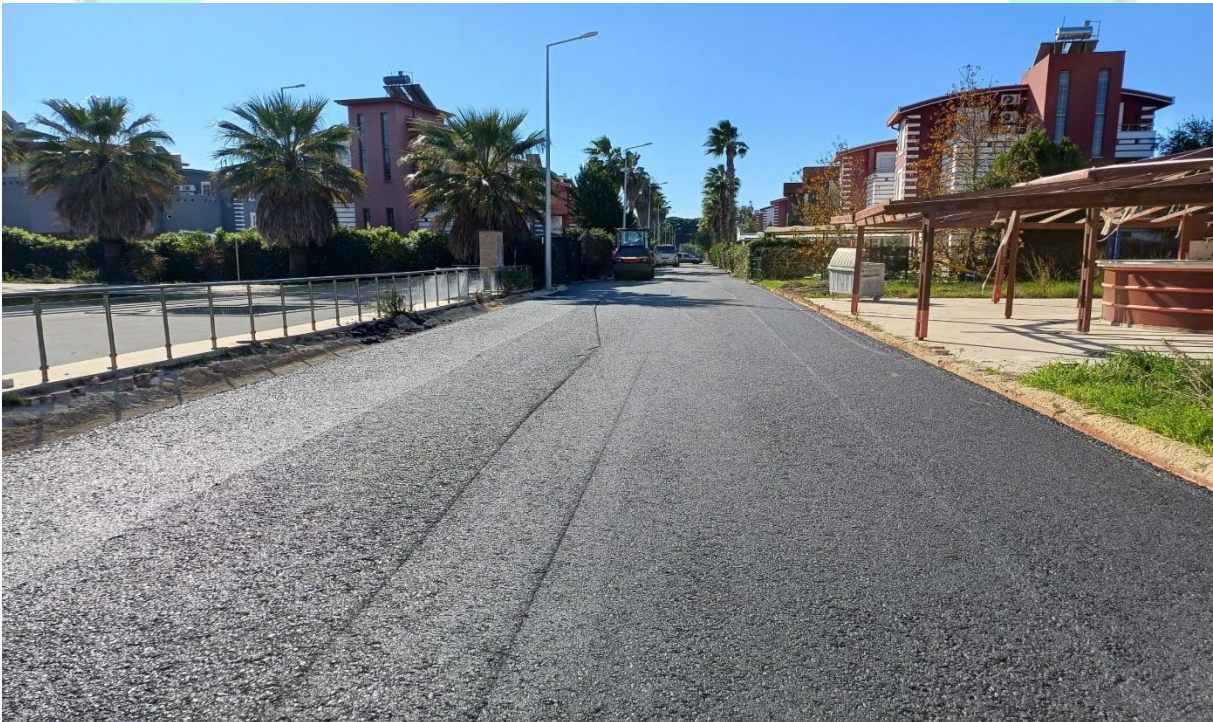
İlgi Fotoğraf: Kadriye Mahallesi 144 Sokak sıcak asfalt serim çalışması yapılmıştır
