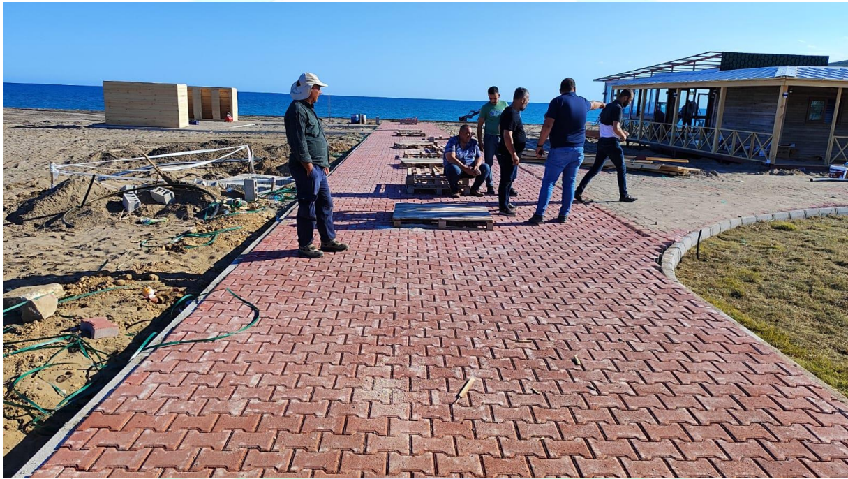
İlgi Fotoğraf: Boğazkent Mahallesi halk plajı kilitli parke taşı döşeme çalışması yapılmıştır
