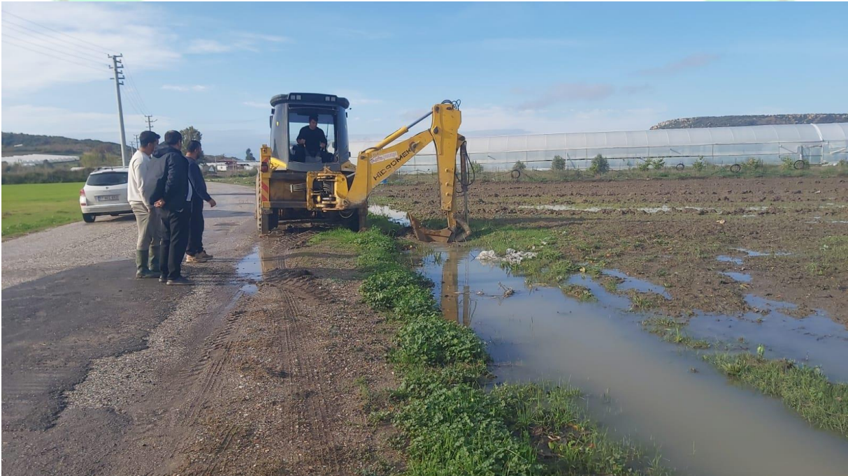
İlgi Fotoğraf: Yanköy Mahallesi yağmur suyu tahliye çalışması yapılmıştır
