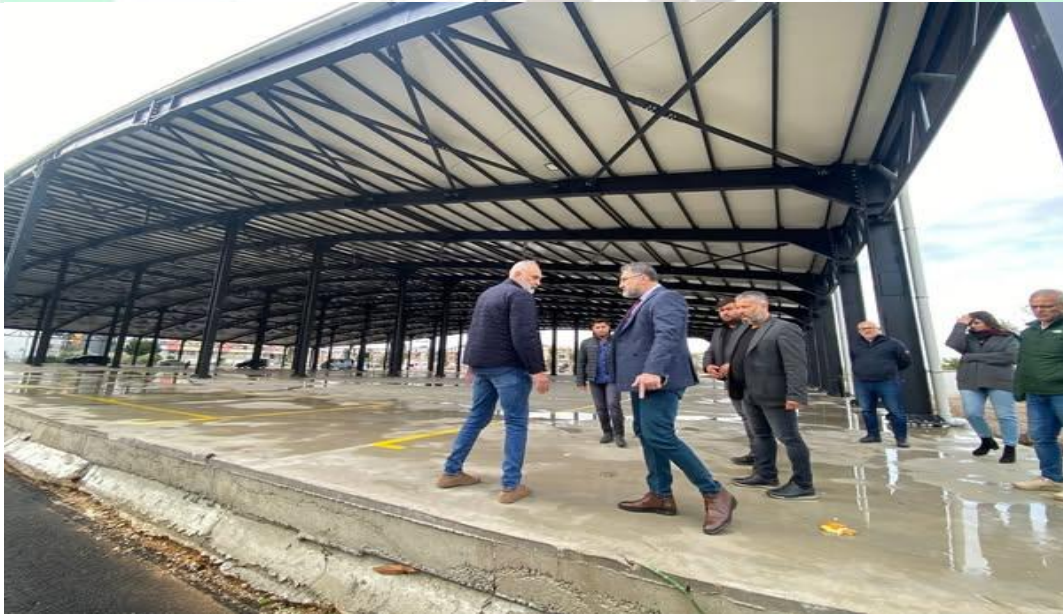
İlgi Fotoğraf: 16 Aralık Pazartesi Belek Kapalı Pazaryeri alanımızda yapılan çalışmaları inceledik.
