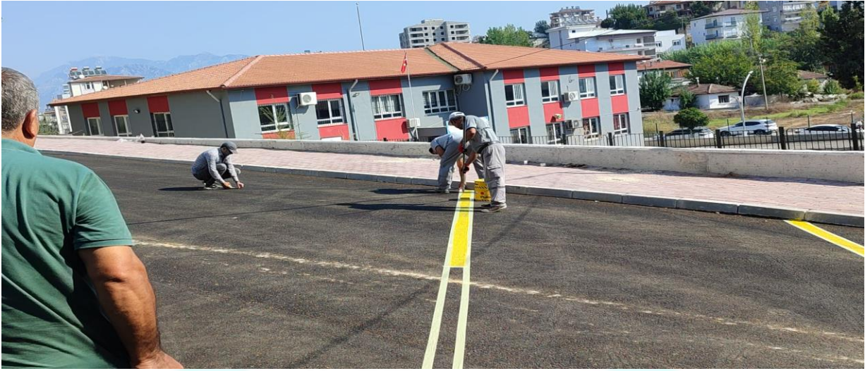
İlgi Fotoğraf: Okul bölgesi çalışmaları
