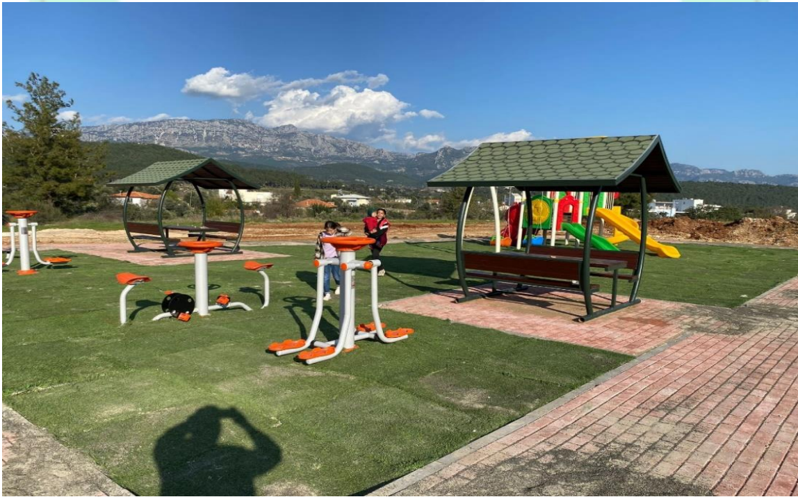
İlgi Fotoğraf: Gebiz Afet Evleri yanı park yapım çalışması tamamlanmıştır.
