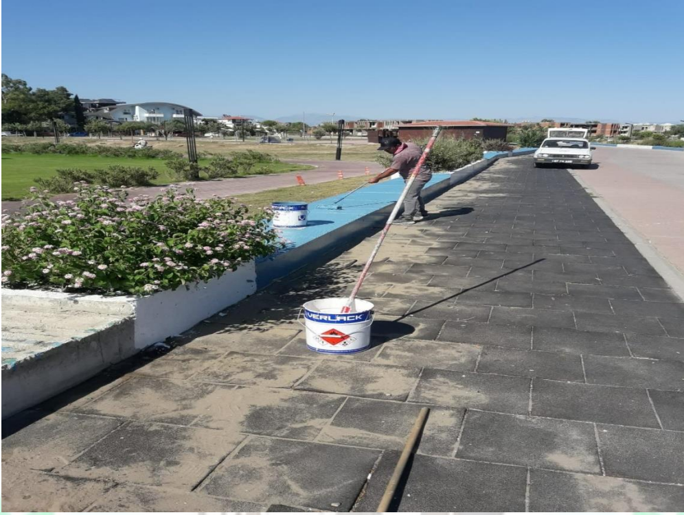
İlgi Fotoğraf: Boğazkent Mahallesi yürüyüş yolu ahşapları sökülüp boyanarak yenilenmiştir.
