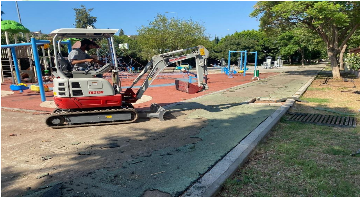
İlgi Fotoğraf: Ramazan Yeşil Parkı yenileme, bakım ve onarım çalışması ile oyun grubu altı SBR yenileme çalışması yapılmıştır.
