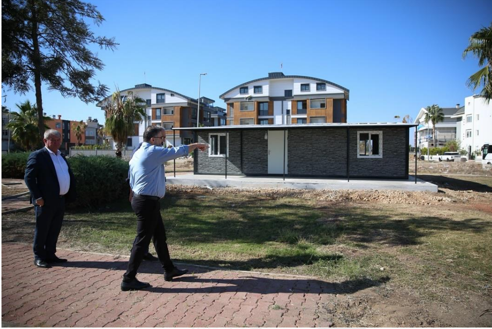
İlgi Fotoğraf: 6 Kasım tarihinde Belek Mahallemizde yapımı devam eden Kur'an Kursu inşaatında incelemelerde bulunduk.
