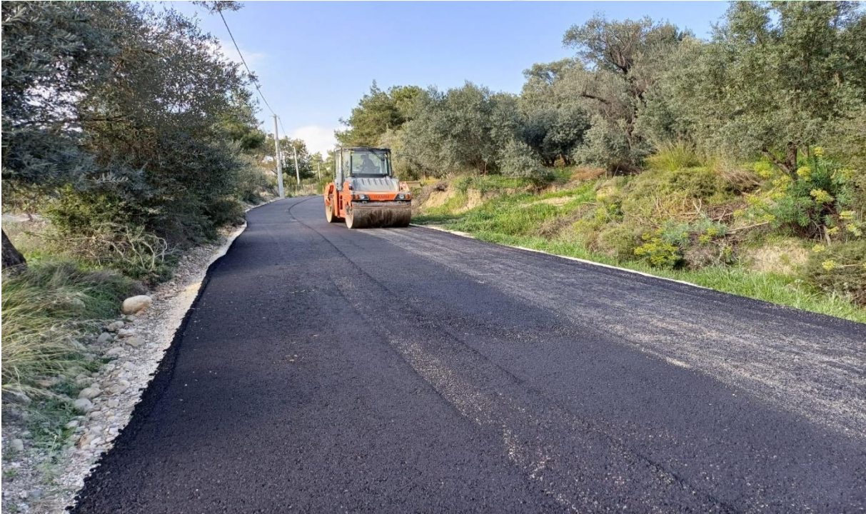
İlgi Fotoğraf: Dorumlar Mahallesi sıcak asfalt serim çalışması yapılmıştır
