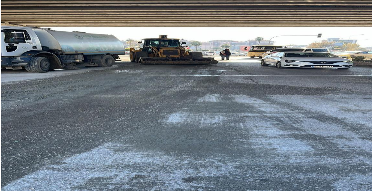
İlgi Fotoğraf: Temizlik ve asfalt çalışmalarında yol güvenlik önlemleri alınması
