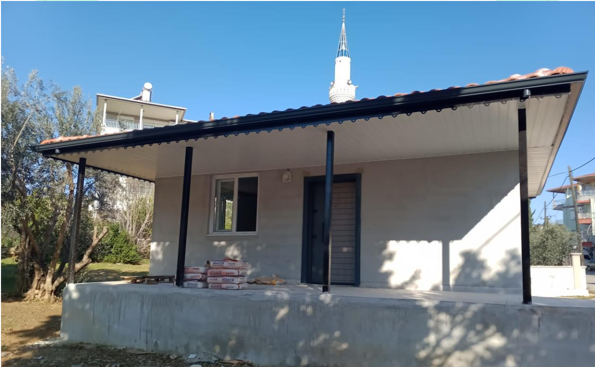
İlgi Fotoğraf: Akçaalan Mahallesi muhtarlık hizmet binası yapılmıştır.
