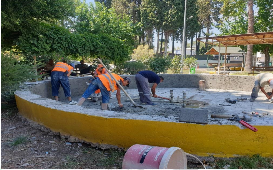
İlgi Fotoğraf: İlçemiz genelinde havuz temizliği, yenilemesi ve bakım çalışmaları yapılmıştır.
