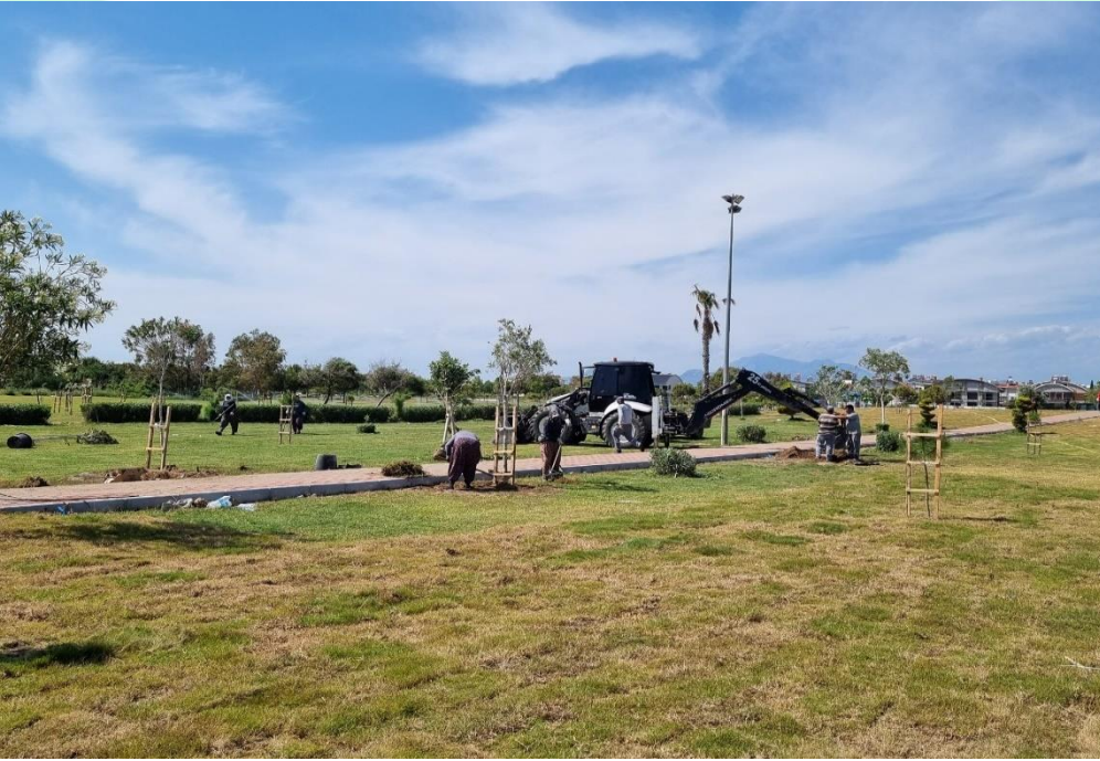
İlgi Fotoğraf: Boğazkent Mahallesi Denizyıldızı restoran çevresi düzenlemesi, elektrik ve sulama hattı çalışmaları, çim serimi, dikim ve peyzaj çalışması yapılmıştır.
