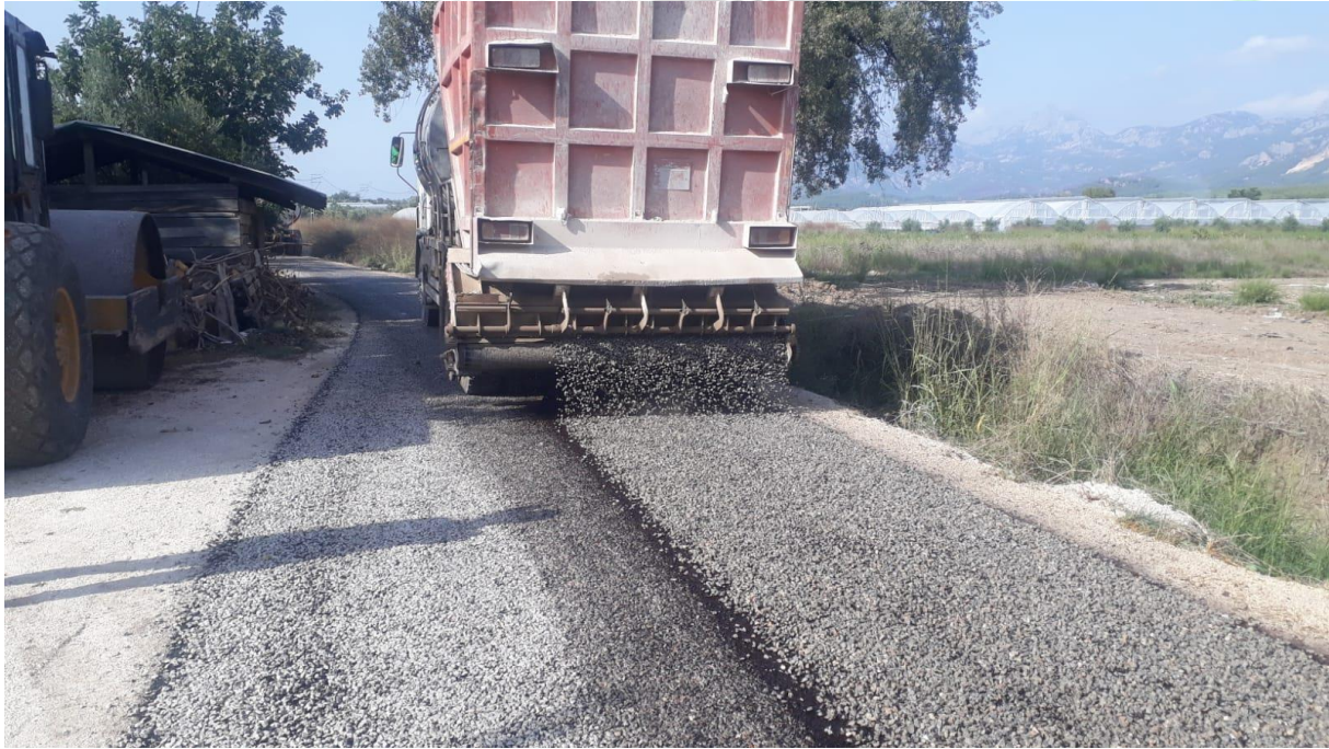
İlgi Fotoğraf: Zırlankaya Mahallesi sathi asfalt serim çalışması yapılmıştır
