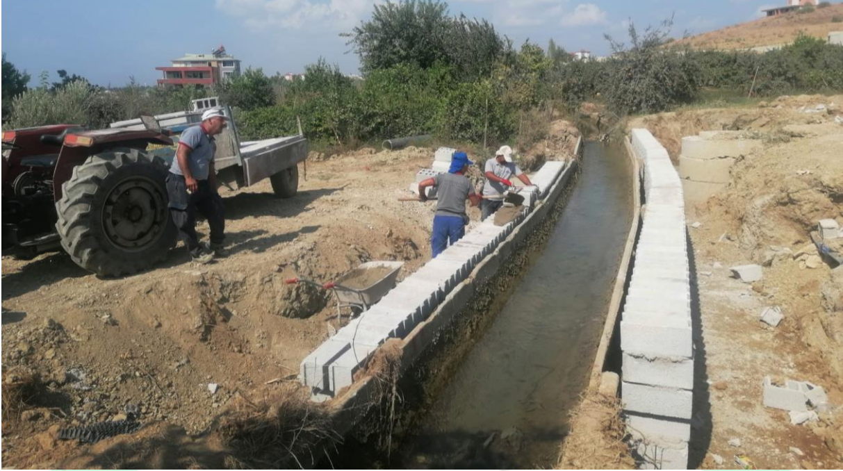
İlgi Fotoğraf: Gedik Mahallesi Akasya Caddesi köprü yapım çalışması yapılmıştır
