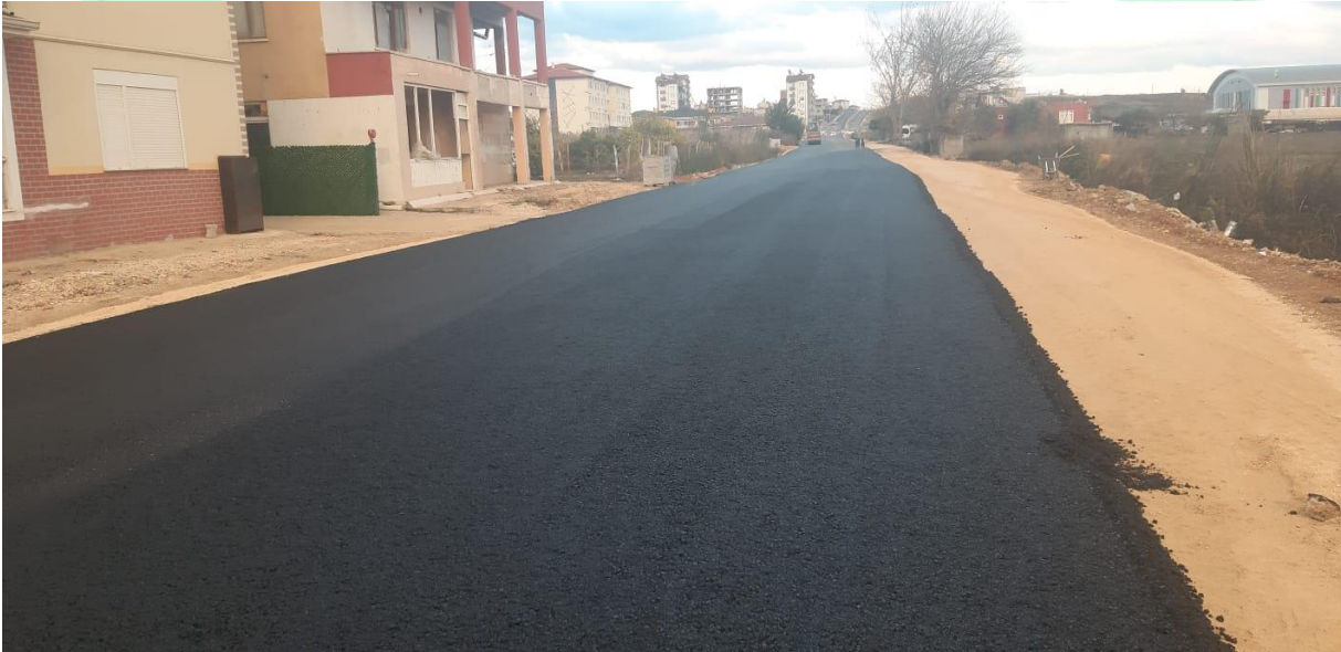
İlgi Fotoğraf: Gedik Mahallesi Akasya Caddesi sıcak asfalt serim çalışması yapılmıştır
