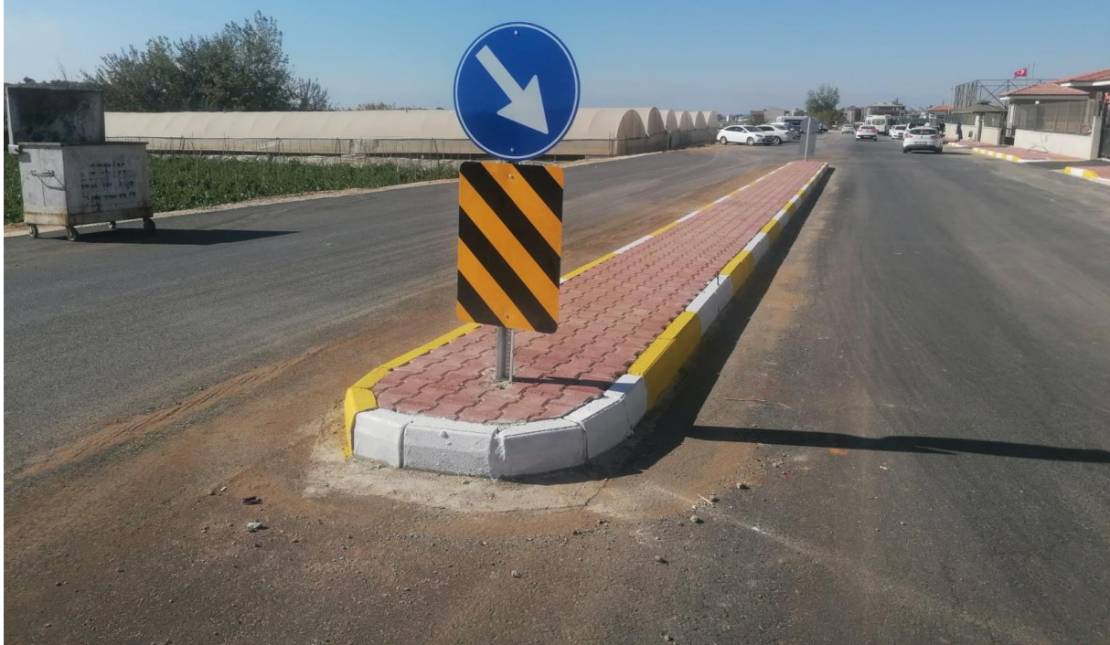
İlgi Fotoğraf: Gedik Mahallesi Akasya Caddesi refüj çalışması yapılmıştır
