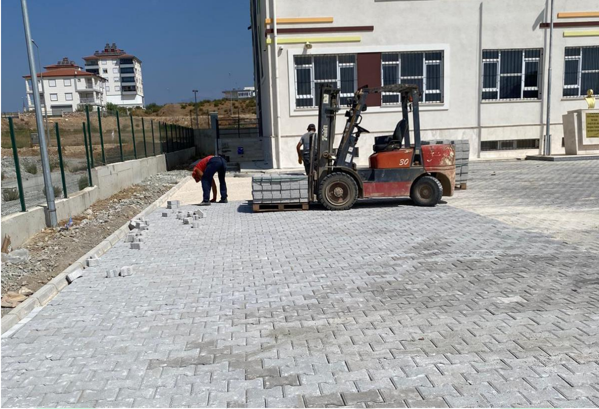
İlgi Fotoğraf: Gedik Mahallesi Gedik İlkokulu bahçesi kilitli parke taşı döşeme çalışması yapılmıştır
