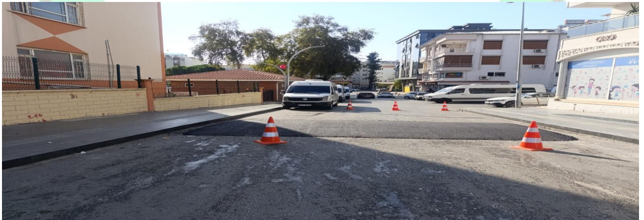
İlgi Fotoğraf: Kasis çalışmaları kontrolleri yapılmıştır.
